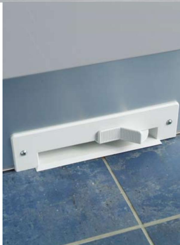
Пневмосовок – это специальная конструкция с узким прямоугольным отверстием для засасывания пыли (в выключенном состоянии отверстие закрыто заслонкой). Он устанавливается на уровне пола в любом помещении, где появляется много мелкого сора, например, на кухне или в прихожей.
